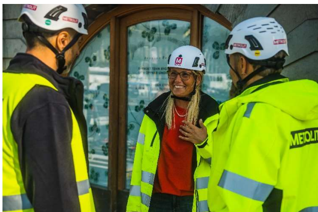
Kollegor; KMA och yrkesarbetare under pågående renoveringsprojekt.
