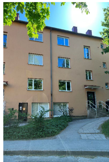
Projekt; Renovering av lägenheter där vi gjorde energibesparingar om 50% jämfört med hur det såg ut innan.
