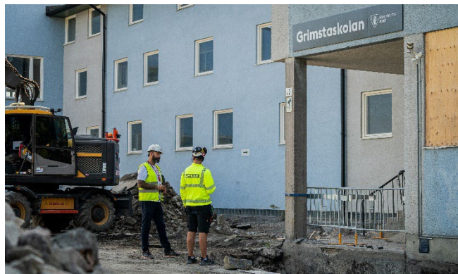
Kollegor; Arbetsledare tillsammans med snickare i pågående renoveringsprojekt.
